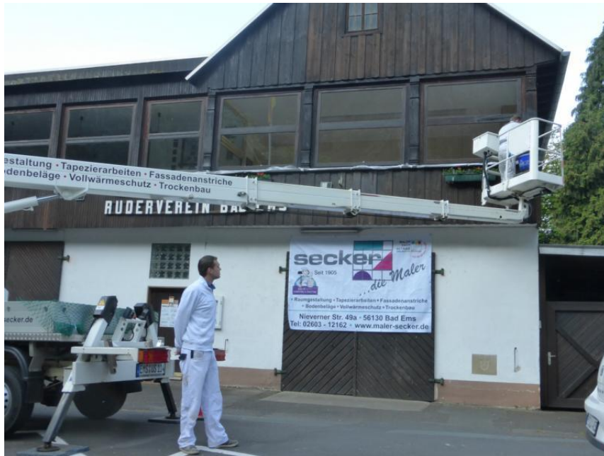
Die Gebrüder Secker im Einsatz mit dem firmeneigenen Hubkran Fahrzeug
